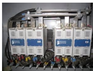
四極轉換掣-電磁接觸器 Auto Change-over contactor (圖：2.31)
